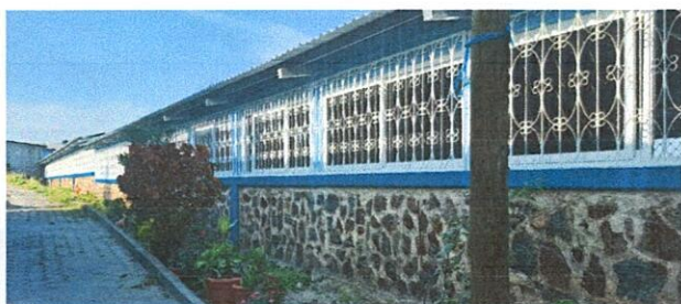
Foto 3: Preparación de la superficie y aplicación de pintura a dos manos, en paredes interiores y exteriores del establecimiento.
